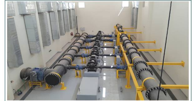
أعمال المياه والصرف الصحي ومحطات المعالجة والضخ
